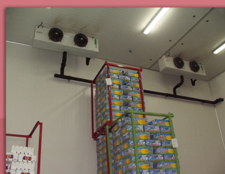
โกดังห้องเย็นเก็บอาหาร และอาคารสำนักงาน ตลาดไท จ.ปทุมธานี
