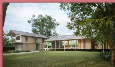
บ้านพักอาศัย 1 ชั้น และ 2 ชั้น จ.สุพรรณบุรี
